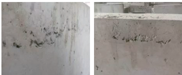
图1 预制构建蜂窝缺陷
