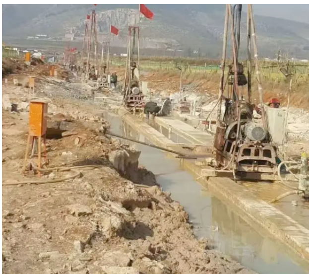
图1 某水库灌浆施工过程
