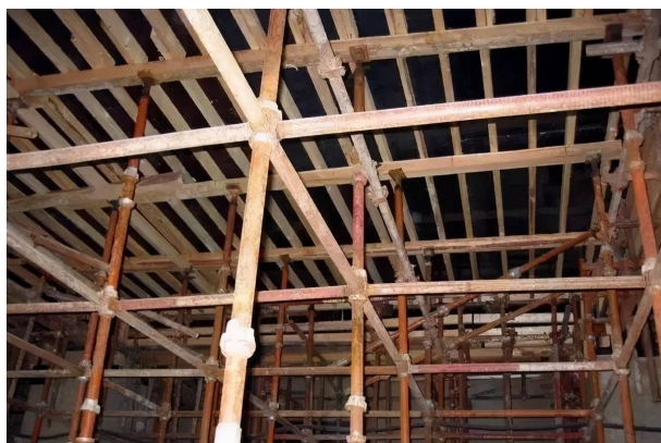
图1 模架支撑体系构建
