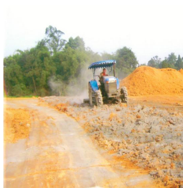
图 4 旋耕机拌合胶结料
