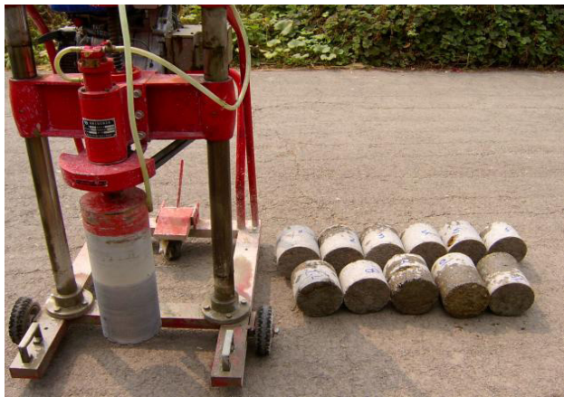
图 6 路面结构钻芯取样
