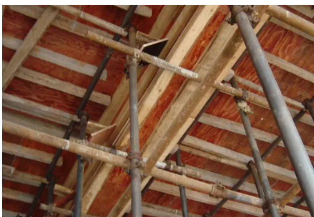
图1 安装高支模支架
