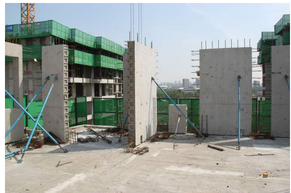
图2 装配式建筑施工
