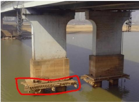
图2 桥梁桥台加固
