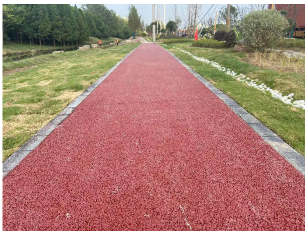
图 2 透水园路铺装、植草沟
