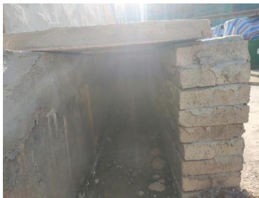
图4 排水沟砌筑示意图
