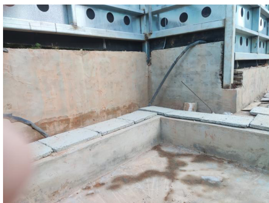
图5 排水沟 90^\circ 转角处处理示意图
