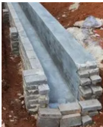
图3 排水沟砌筑过程图
