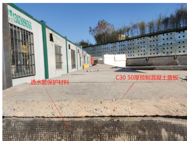
图7 混凝土盖板示意图
