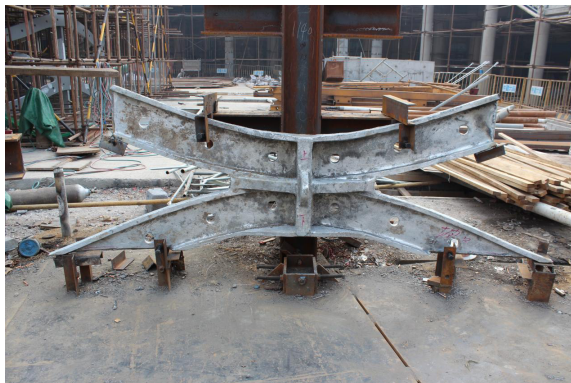
图5 首层铸钢构件装配照片
