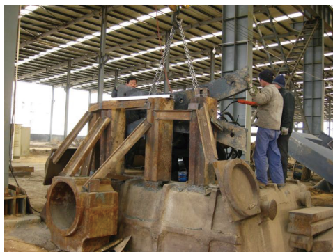
图2 铸钢构件现场矫正照片
