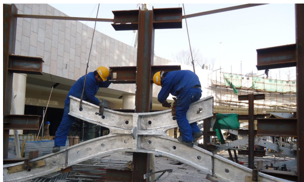
图6 第二层铸钢构件装配照片
