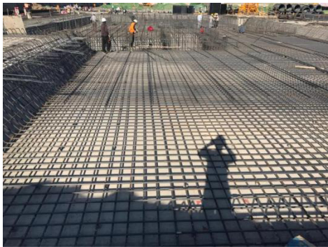
图1 钢筋混凝土施工
