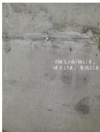
图1 挡土墙典型裂缝
