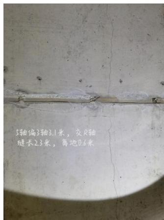
图2 挡土墙典型裂缝
