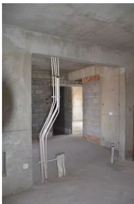
图 2 项目 2: 外滩壹号城中村改造项目现场
