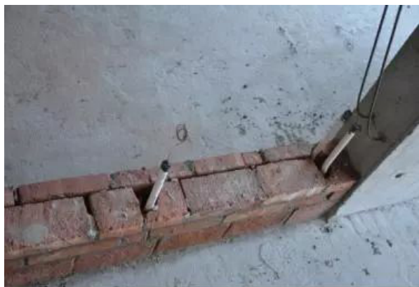
图3 砌筑过程留出管道占据空间
